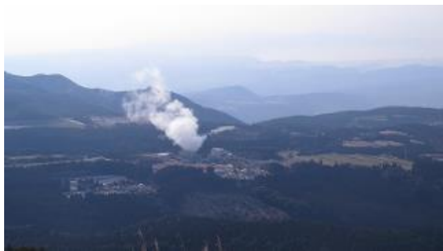
栗野岳中腹に位置する大霧地熱発電所
